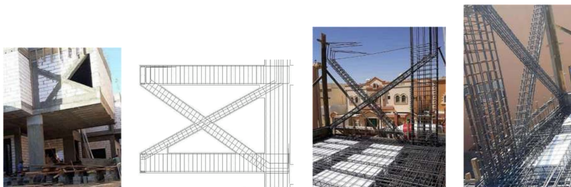
Фигура 2. Диагонално укрепване (като носеща конструкция)
