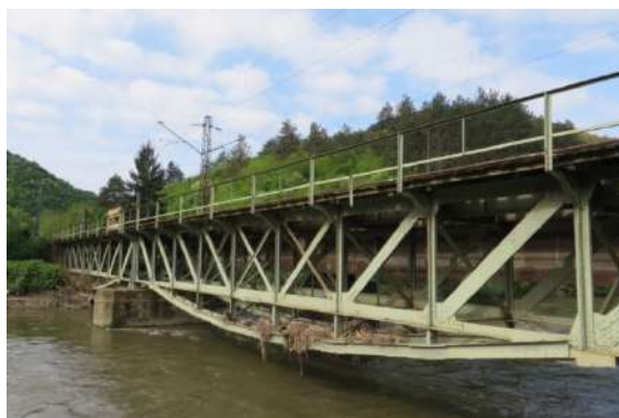
Фигура 7. Стар стоманен нитован железопътен мост с главни греди ферми и отвор L=31,23 m
