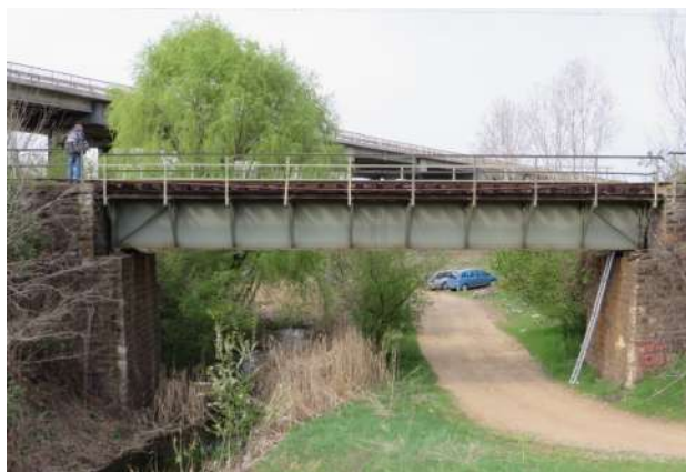
Фигура 5. Стар стоманен нитован железопътен мост с пълностенни главни греди и отвор L=15 m
